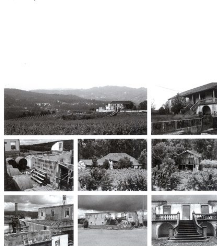
Edifício existente antes da intervenção Existing building before intervention
